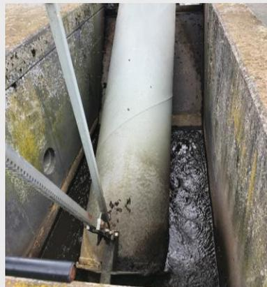
Austausch der Schneckenpumpen durch eine Tauchmotorpumpe, zur Sicherstellung der Rücklaufschlammförderung.
